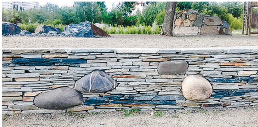
Рис. 5. Образец кладки на фрагменте подпорной стенки. Фото Ю. А. Родионова, 2019 г.
